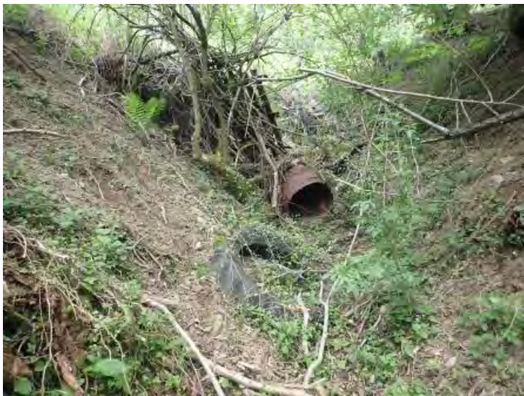
Entrée N7-a et sa décharge
