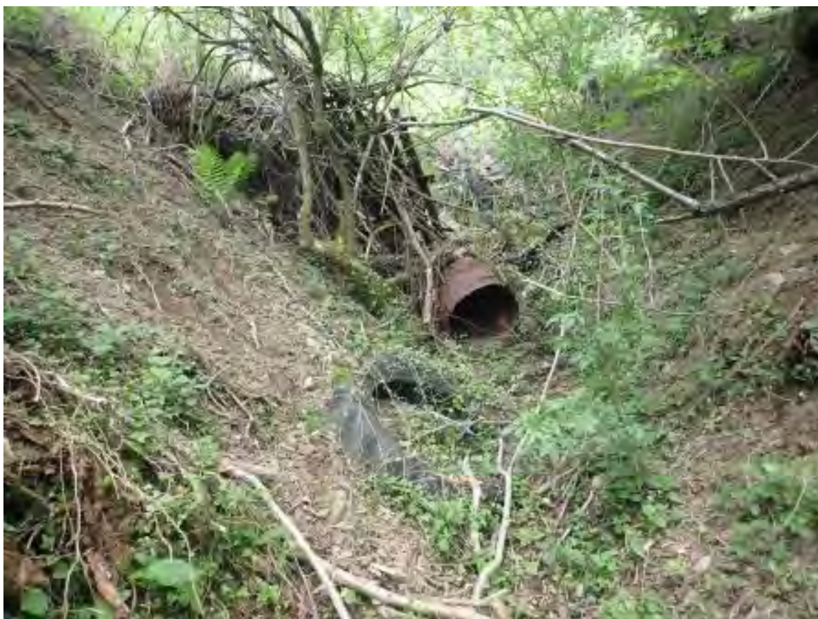
Entrée N7-a et sa décharge
