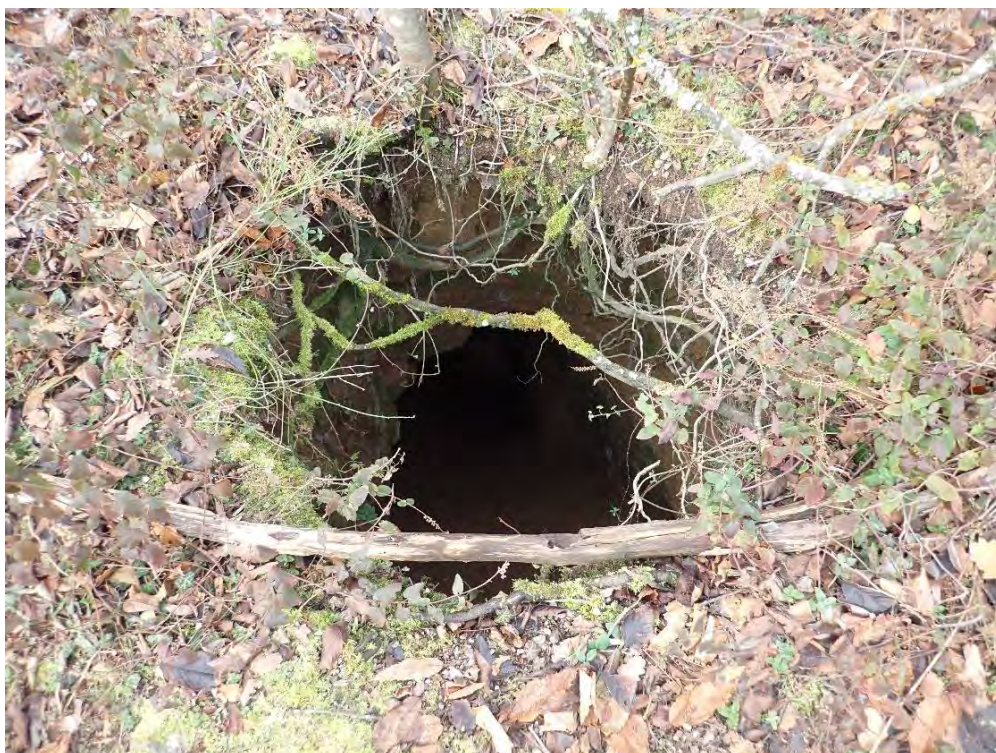
N3-f : Sommet du puits est instable
