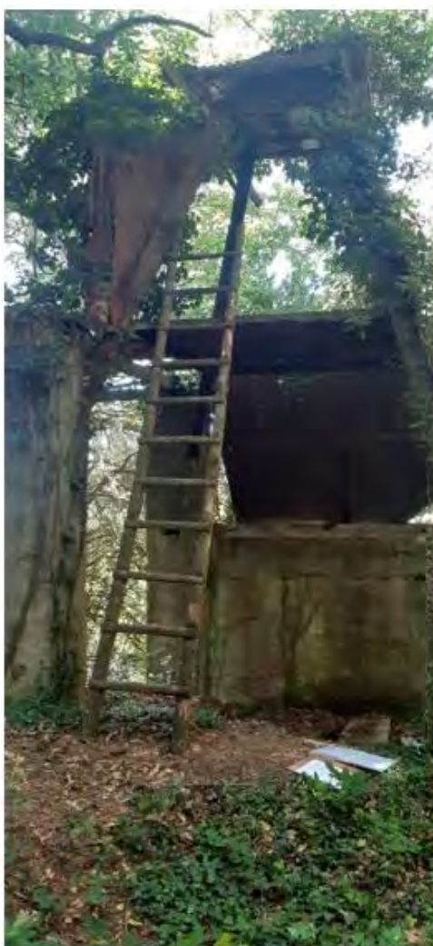
Vue extérieure du chevalement
